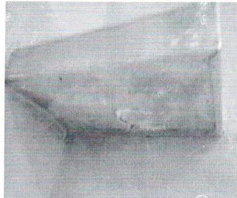
**Foto 2:** Desprendimiento de pintura y materia de superficie en parte baja de repisa donde colocan material para desinfección
